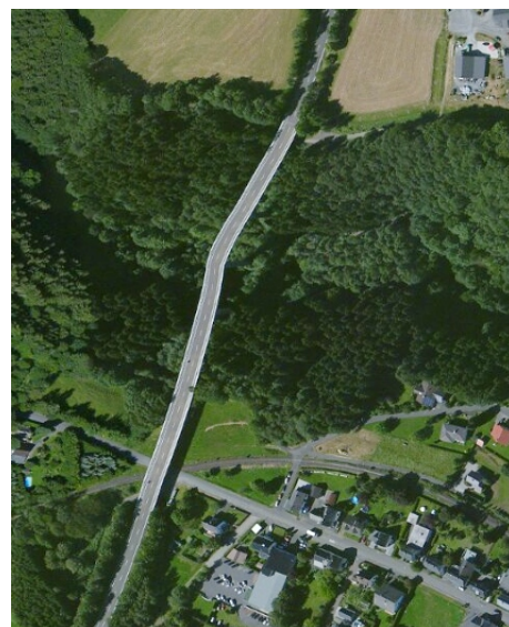
Abbildung 11: Die Talbrücke der L 288 über den Elbbach bei Elkenroth im Westerwald. Bauleitung unter Drogen? GPS-Spuren vom OSM-Server verlaufen alle schnurgerade über das Tal, die Brücke ist also in Ordnung. Hier wurde die Entzerrung des Luftbildes vom Gelände beeinflusst. (Esri World Imagery)
