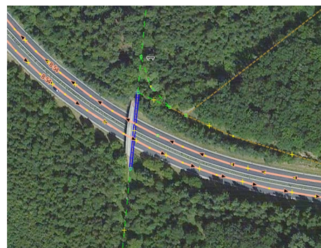
Abbildung 11: Entzerrung von Schrägaufnahmen. Der Pfad über die Brücke verläuft schnurgerade ist deshalb auch so gemappt. Die Brücke macht auf dem Bild nur deshalb eine Kurve nach links, weil die Entzerrung des schräg von rechts aufgenommenen Bildes die darunter verlaufende Bundesstraße an die richtige Position gezogen hat.
