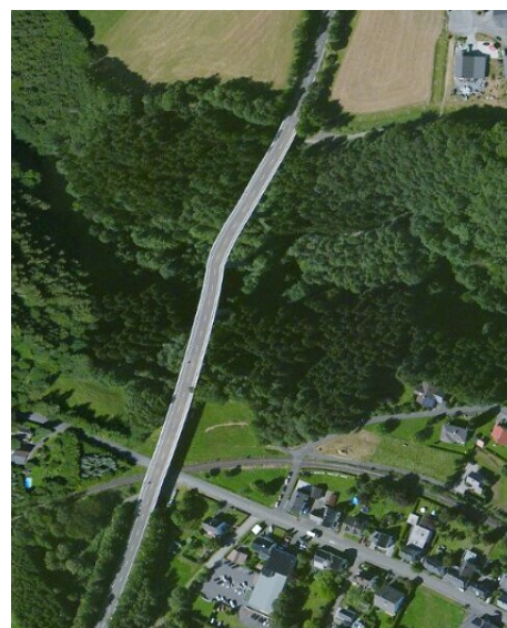
Abbildung 11: Die Talbrücke der L 288 über den Elbbach bei Elkenroth im Westerwald. Bauleitung unter Drogen? GPS-Spuren vom OSM-Server verlaufen alle schnurgerade über das Tal, die Brücke ist in Ordnung. Hier wurde die Entzerrung des Luftbildes vom Gelände beeinflusst. (Esri World Imagery)
