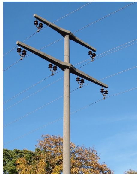
Abbildung 26: 20-kV-Mittelspannungsleitung: power=minor_line , Mast: power=pole . An den Way kann außerdem noch: voltage=20000 ; frequency=50 ; cables=6 ; circuits=2 ; wires=single . Diese Werte aber bitte nur taggen, wenn du dir sicher bist, dass sie stimmen! Nicht jedes Mittelspannungsnetz arbeitet mit 20 kV.
